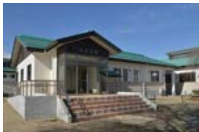
完成した本館管理棟
