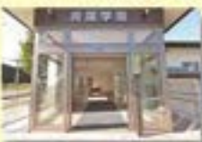
管理棟正面入り口
