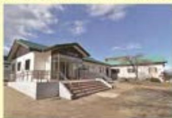
完成した本館管理棟
